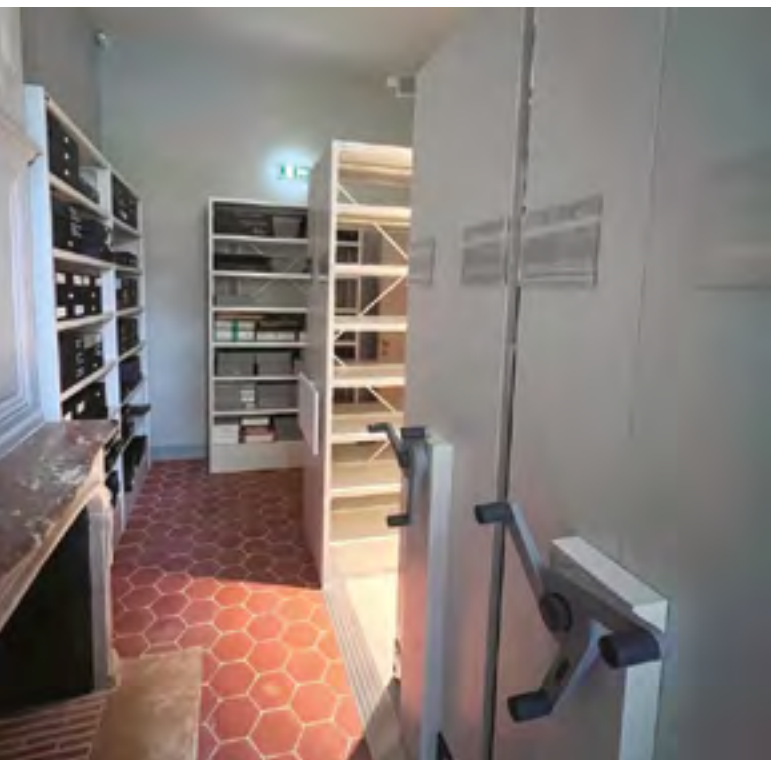
> Installation de rayonnages mobiles
